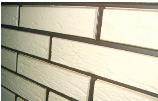
An Mauerimitaten aus Kunststoff wird die Fuge mit Automatik-Spritzpistolen randscharf spritzlackiert
